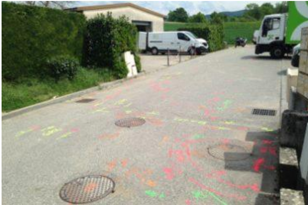
Marquage piquetage avec les profondeurs des réseaux et le couloir d'imprécision du réseau GAZ.
