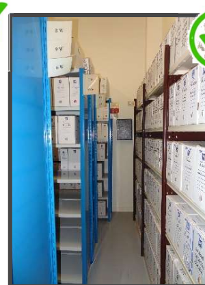
Absence de canalisations et de gaines électriques
