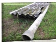
Tôles, tuyau en fibro-ciment
