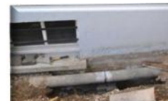
Canalisation, conduite d'eau
