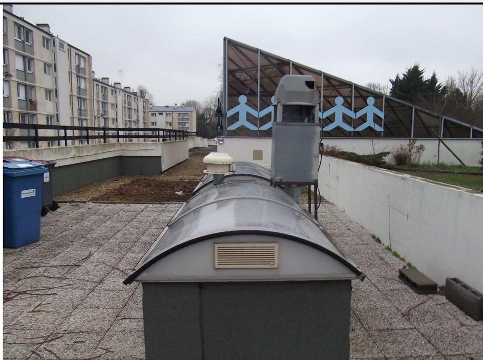
Photographie n°4 – Dispositif de ventilation en toiture
