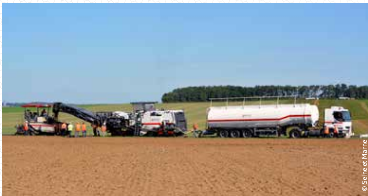
En Seine-et-Marne, le projet Recyclean teste le recyclage en place des enrobés contaminés.
