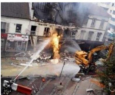
Photo : lors d'un chantier de voirie près d'un restaurant à Bondy 30/10/2007, une pelleteuse perce accidentellement une canalisation de gaz déclenchant une explosion. Une personne est tuée et cinquante autres sont blessées.
