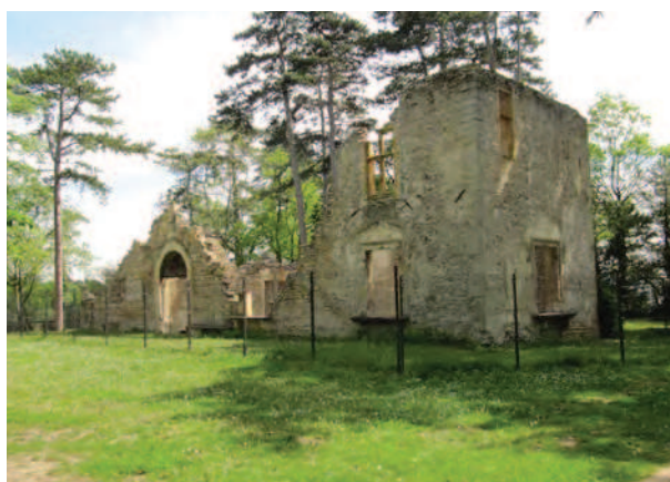
Ruines renaissance, Parc de Beauregard - © Agence d'urbanisme de Lyon
