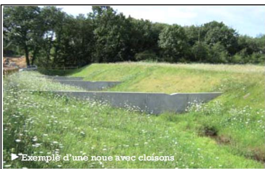
▶ Exemple d'une noue enherbée
