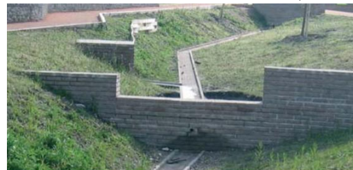
Noues végétalisées à Nanterre (Source : CG 92)
