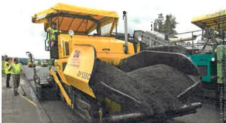
Chantier d'enrobé autoroutier en Lozère. Le taux de réintroduction des agrégats d'enrobés dans les enrobés bitumineux est passé de 5,8 % en 2009 à 12,9 % en 2014.
