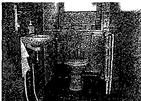
WC commun au bâtiment
